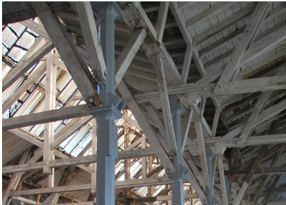
Sanierte Gussstützen
