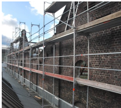
Sicherung Giebel der Halle 1
