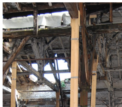
Notabstützung im Tragwerk, Ende 2009
