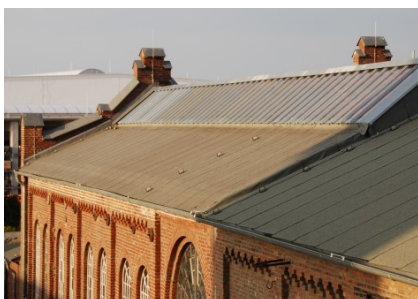
Sanierte Fensterbänder und Mauerwerksbereiche an der Westseite
