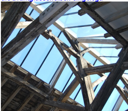
Mittels einer Schablone wurde der Abstand der Fensterprofile ermittelt und die Drahtglasscheiben eingelegt.
