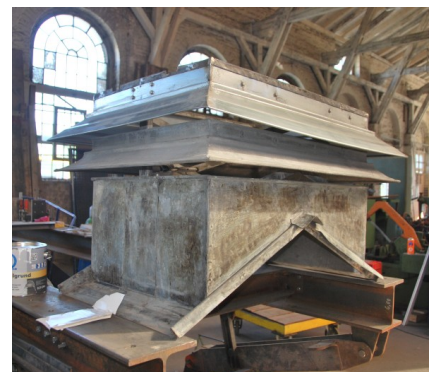
Der fertige Rauchabzug wartet auf die Lackierung und den Wiedereinbau im westlichen Hallenschiff.
