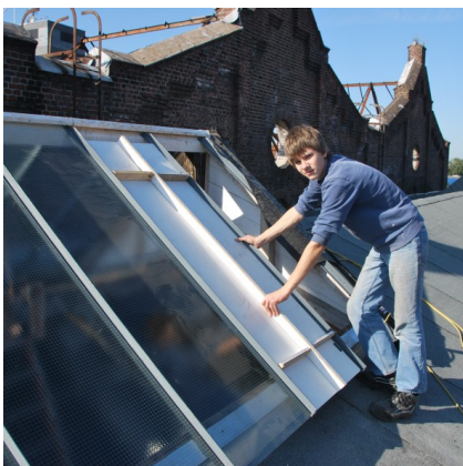
Mittels einer Schablone wurde der Abstand der Fensterprofile ermittelt und die Drahtglasscheiben eingelegt.
