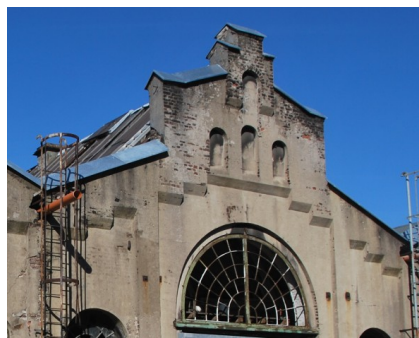
Der Sügiebel hat im September neue Mauerwerksabdeckungen bekommen.
