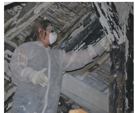
Reinigung des Tragwerks
