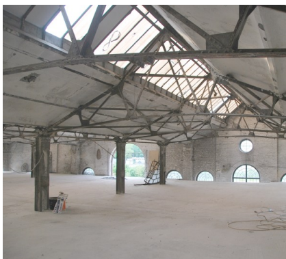
Reinigung der Stahlteile
