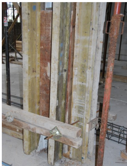
Eingeschalte Stahlstütze
