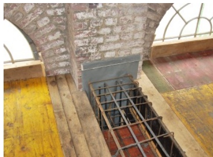
Anschluss der Unterzüge an das Außenmauerwerk
