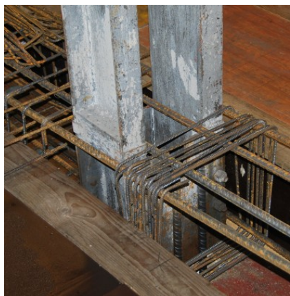
Viel Handarbeit ist für die Erstellung der Unterzüge erforderlich.
