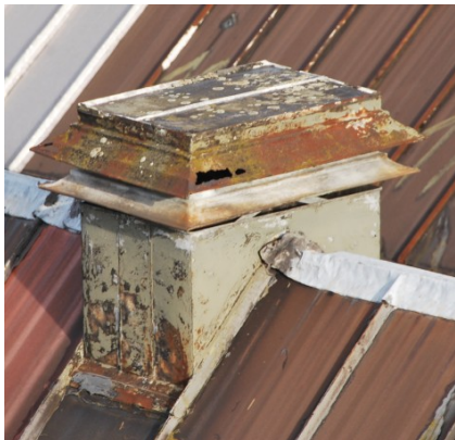
Historischer Rauchabzug vor und nach der Aufarbeitung in unserer Schlosser-Werkstatt. Die Rauchabzüge werden auch für den künftigen Brandschutz benötigt.
