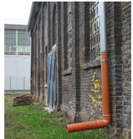
Fallrohr an der Ostseite
