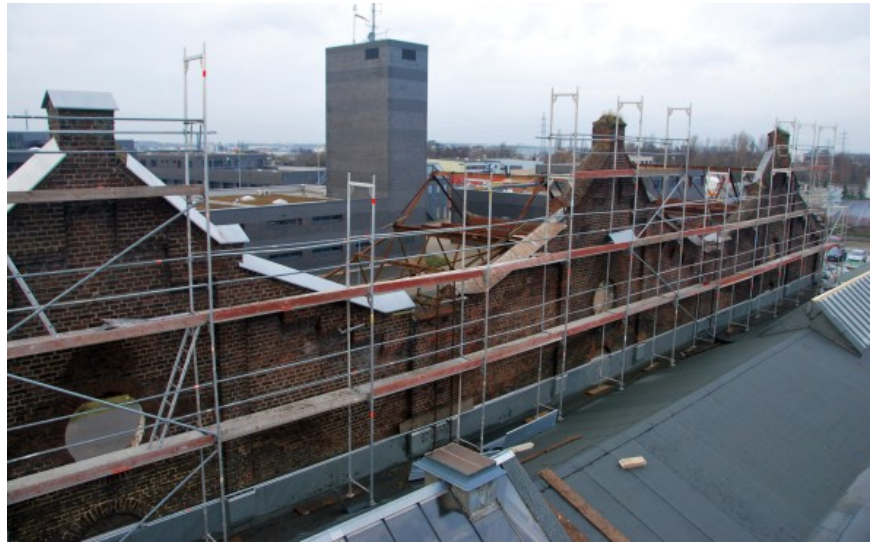
Westgiebel mit Baugerüst und sanierten Fensterbändern im Vordergrund.
