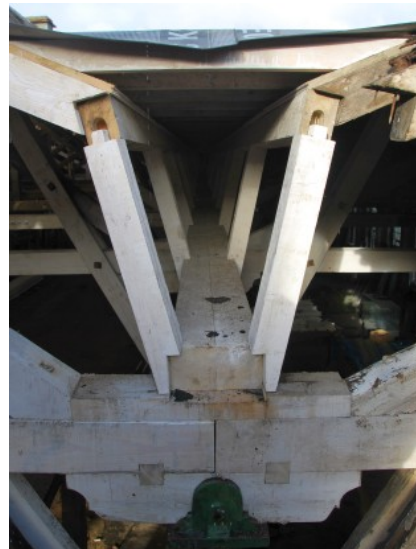
Detailstudien an der neu aufgebauten Kehle an der Süd-Ostseite.
