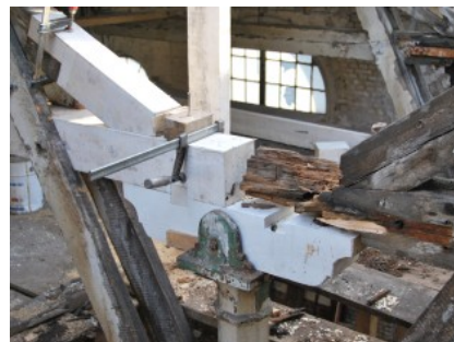
Erneueres (links) und altes, zerstörtes Auflager im Ostschiff
