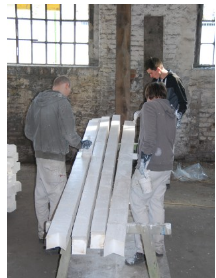
Auszubildende bei der Grundierung der Dachsparren
