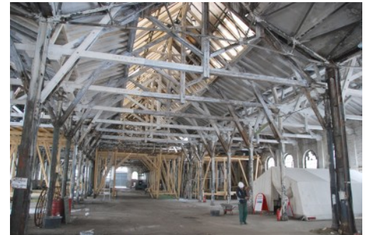
Das Foto von Anfang Dezember zeigt bereits gut den zimmermannsmäßig sanierten Abschnitt und die gewanderten Arbeitsgerüste.
